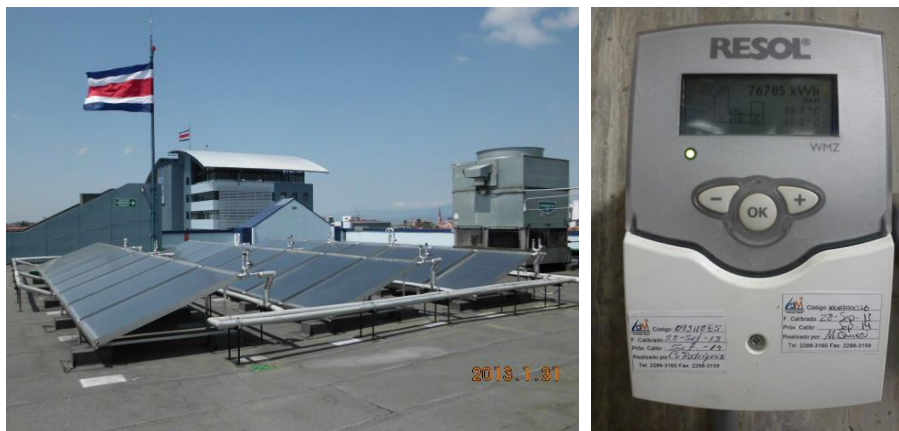
Figura 2: foto de los paneles solares en el Hospital Clínica Bíblica y su calorímetro
